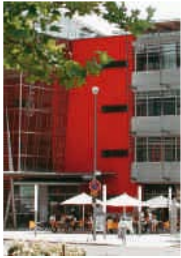
Wirtschaftsstandort Innenstadt: Ehemalige Emaillefabrik Amberg. Mit einer Anstoßfinanzierung durch die Städtebauförderung entstanden am Rande der Amberger Altstadt auf dem Areal einer ehemaligen Emaillefabrik ein Dienstleistungszentrum mit rund 700 neuen Arbeitsplätzen. Ein öffentliches Parkhaus bietet neue, altstadtnahe Parkplätze.
